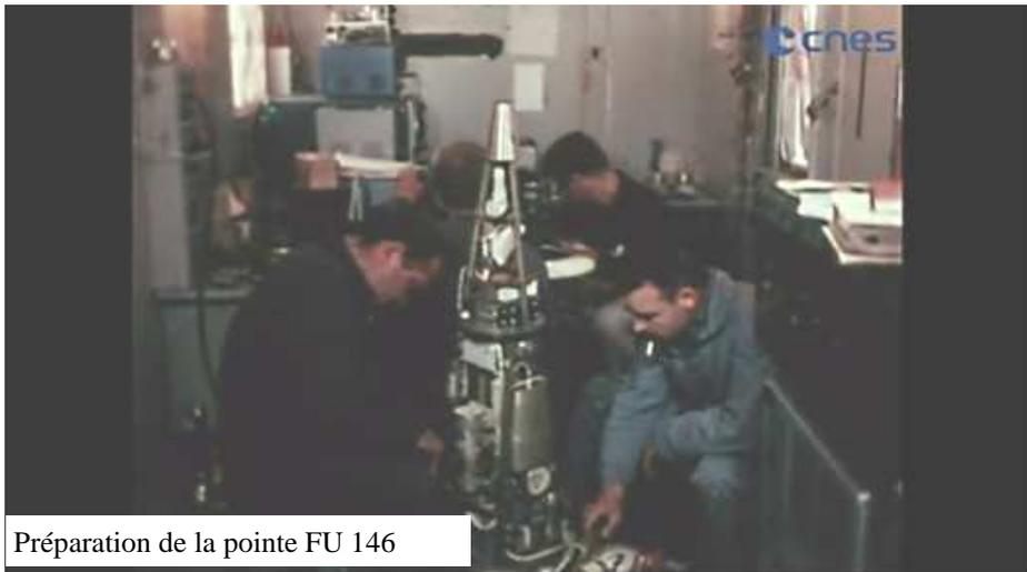
L'architecture de la pointe avant était une copie du modèle précédent, avec cependant la suppression du plateau tournant, la précession de la fusée devant permettre de balayer l'Espace.
